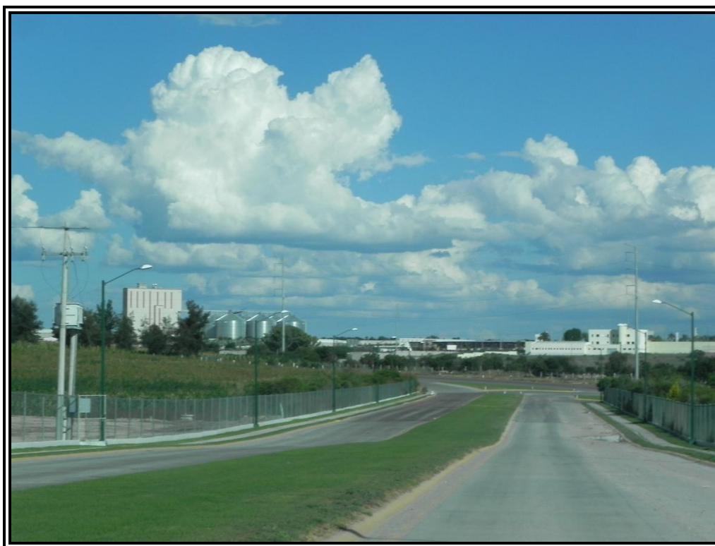
Foto VIII.1.2.8 Vista del Libramiento Periférico por donde quedará instalado el gasoducto de 8”.
