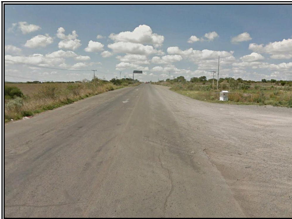
Foto VIII.1.2.5 Derecho de vía de la carretera por donde quedará instalado el Ramal de 4”.
