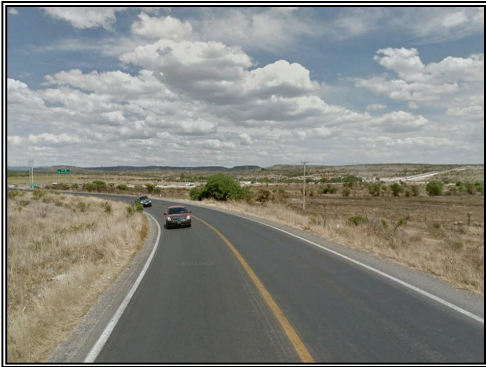
Foto VIII.1.2.4 Derecho de vía de la carretera por donde quedará instalado el gasoducto de 8”.
