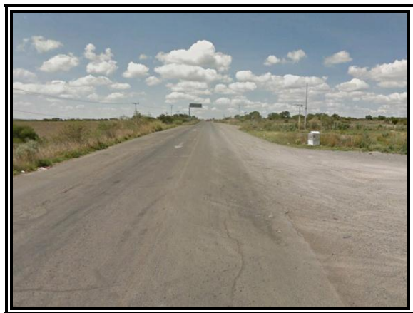
Foto II.1.1.5 Derecho de vía de la carretera por donde quedará instalado el Ramal de 4".
