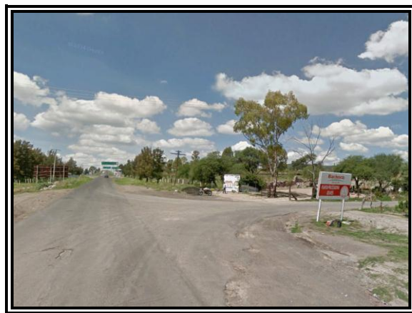
Foto II.1.1.6 Cambio de dirección del gasoducto de 4" hacia las instalaciones de Bachoco.
