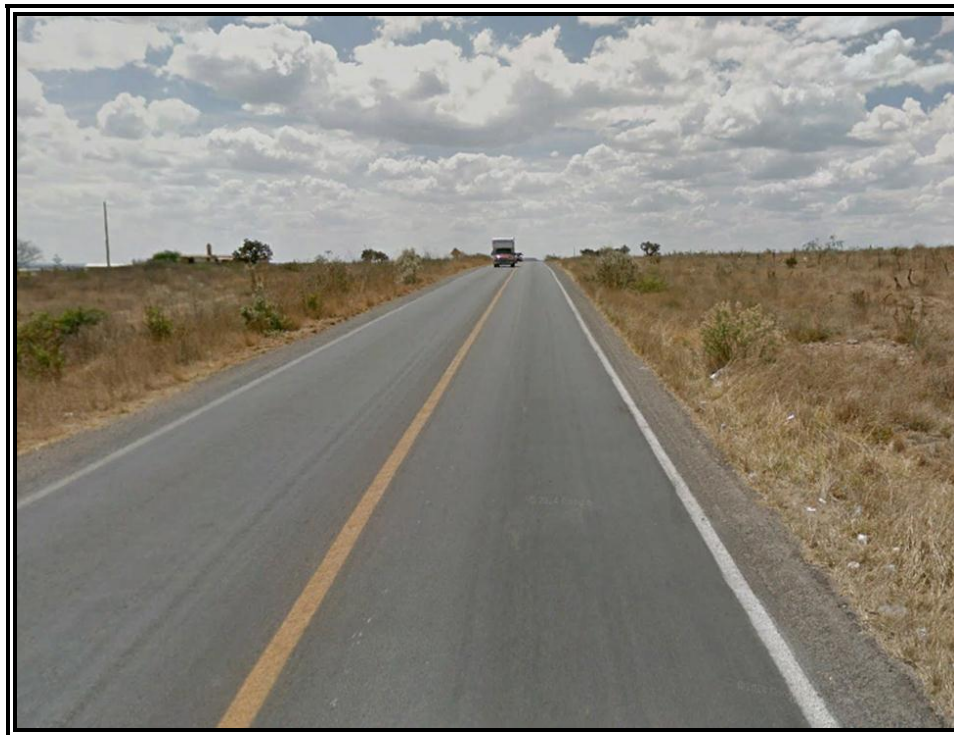
Foto VIII.1.2.3 Derecho de vía de la carretera por donde quedará instalado el gasoducto de 8”.
