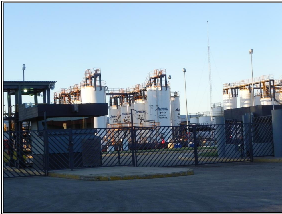
Foto VIII.1.2.12 Instalaciones de la empresa AKRON (socio comercial).
